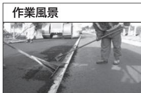
●舗装ジョイントの継ぎ目割れを防止します。
